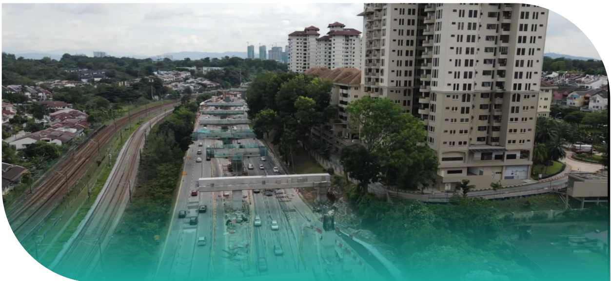
Gambar 32: Pembinaan Struktur Pier Crosshead di Seksyen 1 : Kerinchi Ke Salak
