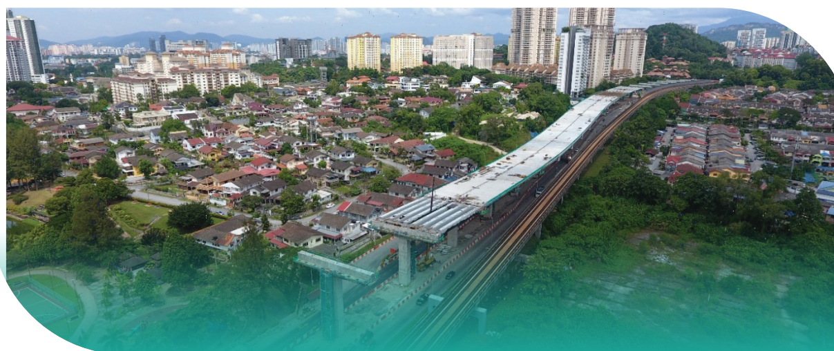
Gambar 38: Pembinaan jajaran utama di Jalan Jelatek di Seksyen 2 : Salak ke Pandan Photo 38: Construction of main alignment at Jalan Jelatek in Section 2 : Salak to Pandan
