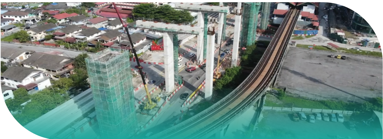
Gambar 44: Kerja pembinaan struktur pier column di Jalan Jelatek Pandan ke Setiawangsa di Seksyen 3
