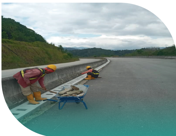
Gambar 73: Ch 13800 ke Ch 14000 RHS : Kerja-kerja pembersihan sisa bahan binaan di bahu jalan.
