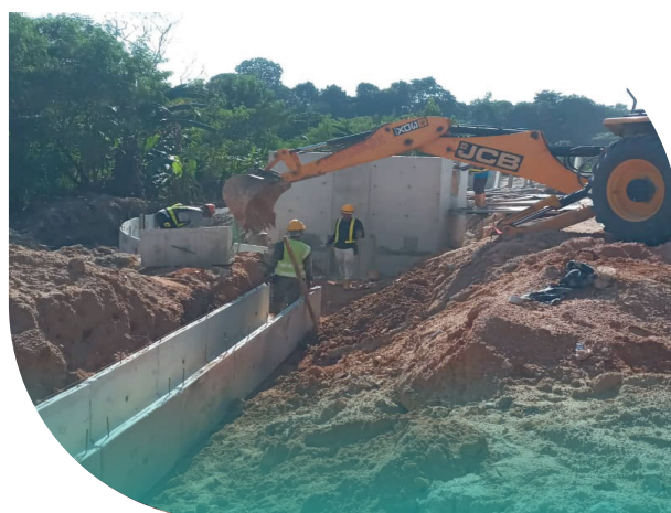
Gambar 76: BR 21 / Jalan Susur Ampang : Pemasangan Longkang Jenis RUD 600 untuk Disambungkan ke Turas Takungan
