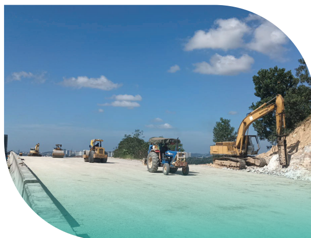
Gambar 74: Ramp 1B Ch 330 LHS : Pembinaan Longkang dan Pemecahan Batu sedang dijalankan.
