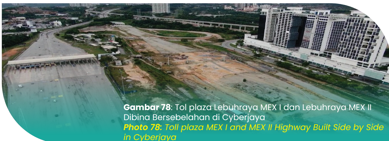
Gambar 77: Pembinaan Jambatan Berhampiran Lebuhraya Putrajaya - Dengkil-KLIA (E29), Projek Cybersouth dan Bandar Dengkil. Photo 77: Construction of Bridge Near Putrajaya -Dengkil-KLIA Highway (E29), Projek Cybersouth and Bandar Dengkil.
