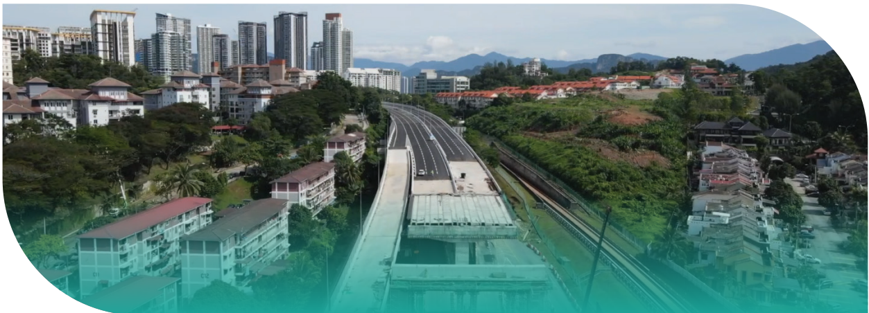
Gambar 46: Pembinaan Struktur Crosshead di Seksyen 4 : Setiawangsa ke Taman Melati Photo 46: Construction of Crosshead Structure in Section 4 : Setiawangsa to Taman Melati
