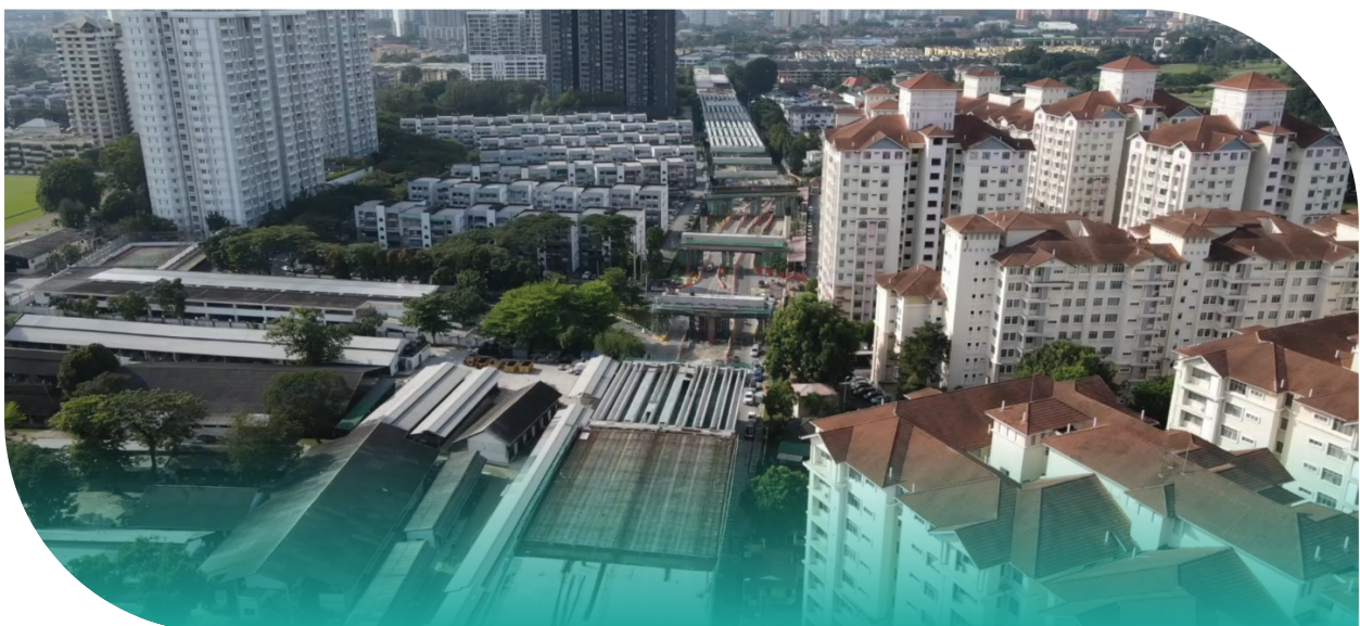
Gambar 42: Pembinaan Deck Slab di Seksyen 3 : Pandan ke Setiawangsa
