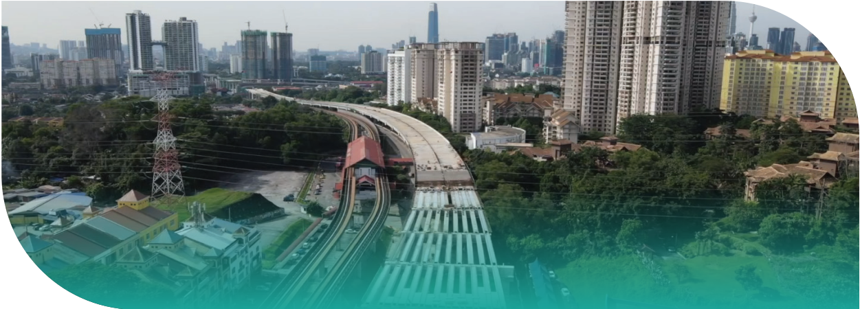
Gambar 43: Pembinaan Deck Slab di Seksyen 3 : Pandan ke Setiawangsa Photo 43: Construction of Deck Slab in Section 3 : Pandan to Setiawangsa
