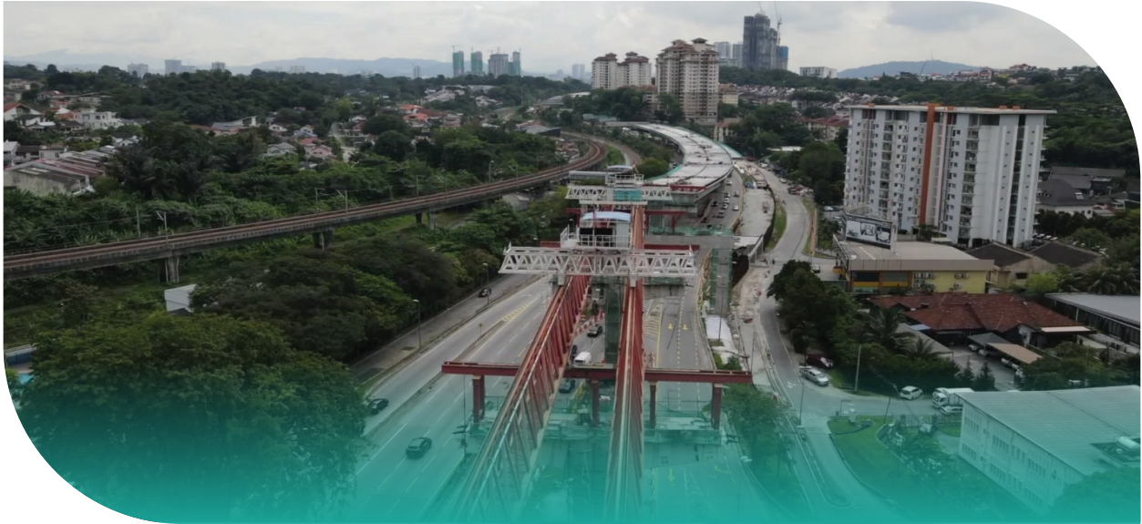
Gambar 31: Gambar 30: Persediaan Mengangkat Rasuk semasa Membina Lebuhraya SPE di Seksyen 1: Kerinchi ke Salak
