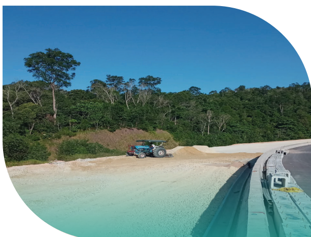
Gambar 75: Ch 12530 ke Ch12390/ LHS : Kerja-kerja Penambakan sedang Dijalankan.
