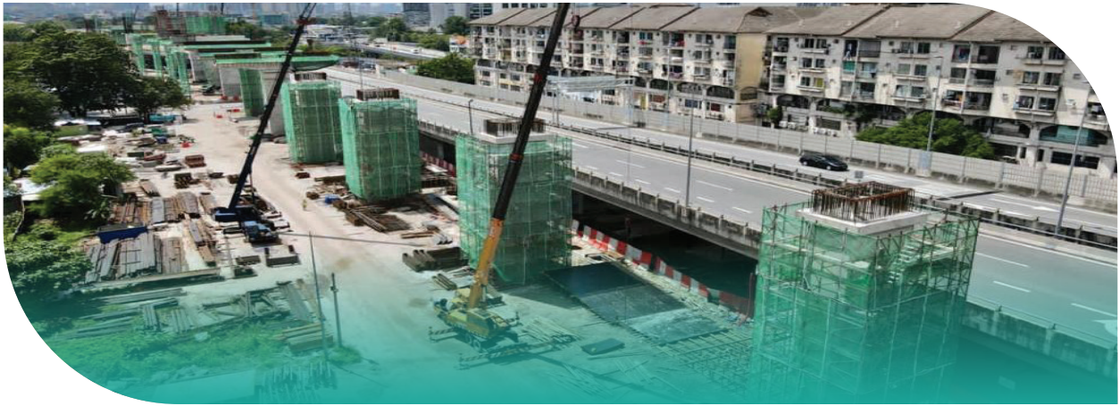
Gambar 40: Pembinaan struktur column dan crosshead di Seksyen 2 berhampiran Jalan Loke Yew di Seksyen 2 : Salak ke Pandan
