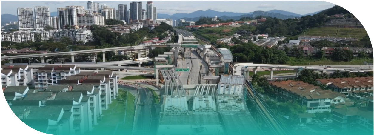
Gambar 45: Pembinaan Deck Slab di Seksyen 4 : Setiawangsa ke Taman Melati Photo 45: Construction of Deck Slab in Section 4 : Setiawangsa to Taman Melati
